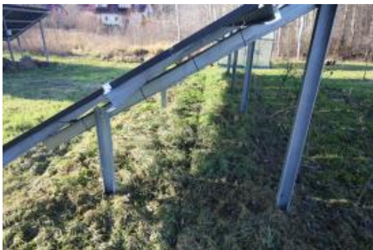
Fotografia 11. Teren pomiędzy i pod panelami nie jest utwardzony [źródło: własne archiwum]
